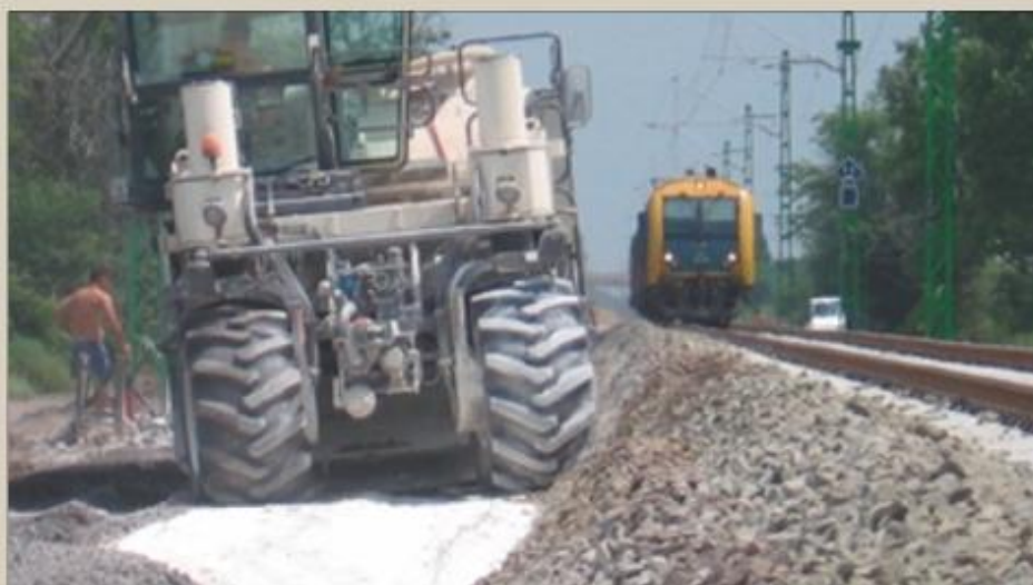
Meszes stabilizáció vasúti töltés építésénél
