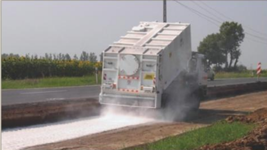
Őrölt égetett mész szórása útszélesítésben
