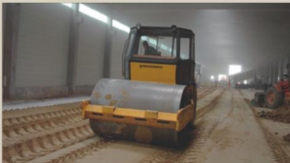
Végleges tömörítés csarnokban
