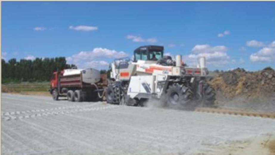
Cement stabilizációs réteg építése védőrétegen
